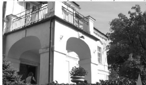
Domov důchodců v Jesenci sídlí v objektu bývalého zámku, který je dominantou okolí
